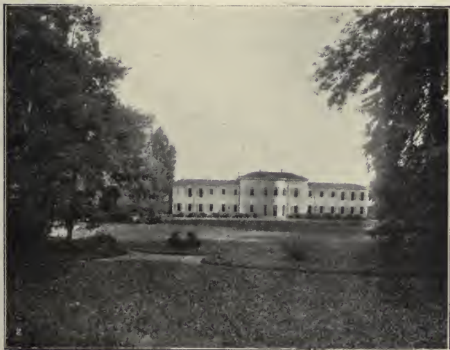
Facciata verso il giardino.
